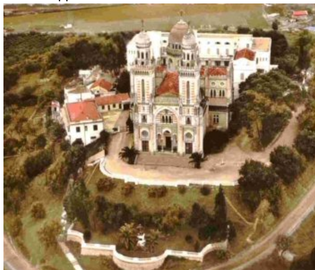
Eglise Saint Augustin Eglise Saint Augustin à Annaba
